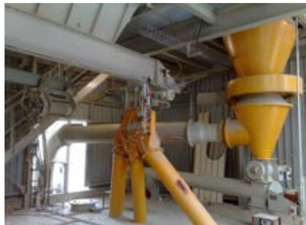
Sichterunterteil mit Förderer zur Kugelmühle
