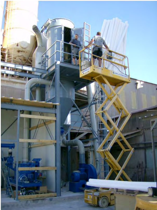
Montage von Filterelementen
