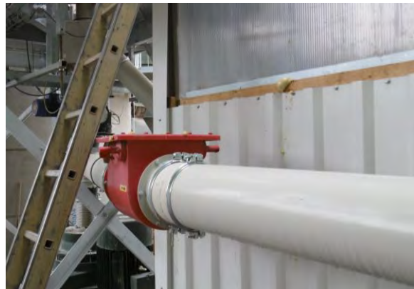
Zuluftleitung mit Rückschlagklappe
