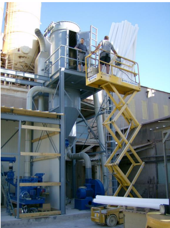
Einbau der Filterschläuche
