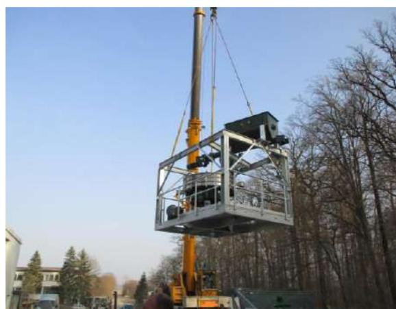
Die Anlagenmodule können auch in 20ft-Container-Chassis eingebaut werden, dadurch ist kostengünstiger Überseetransport und schnelle Montage vor Ort möglich, ebenso die einfache Demontage und Verlagerung der Anlage
