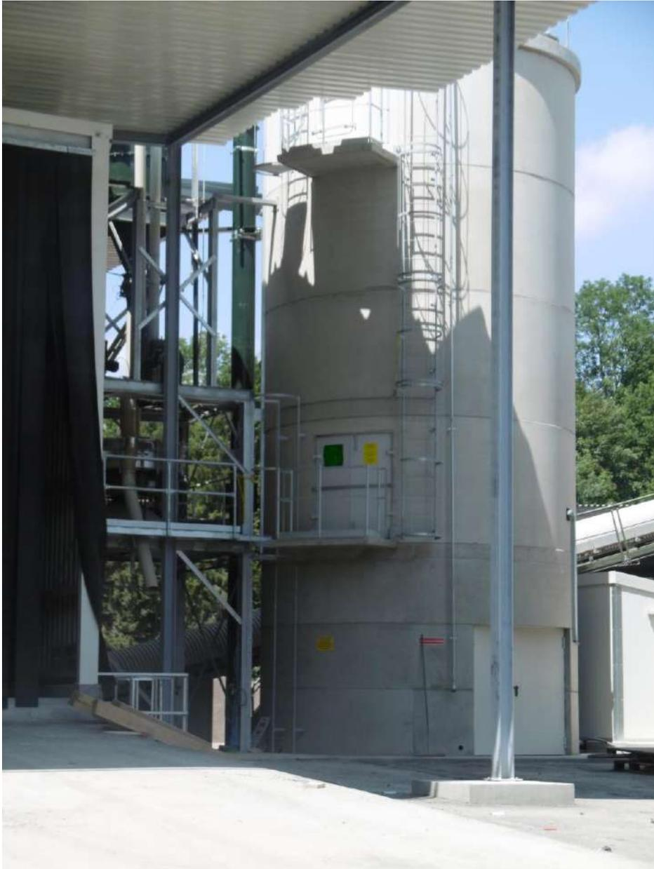
Für zuverlässigen Materialaustrag aus dem Silo sorgt ein Förderschneckensystem das die gesamte Silogrundfläche abdeckt. Dadurch werden Materialverstopfungen und Brückenbildung im Silo zuverlässig verhindert.
